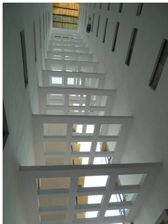
PINTURA PATIO LUCES | C/ Cronista Carreres. Valencia
