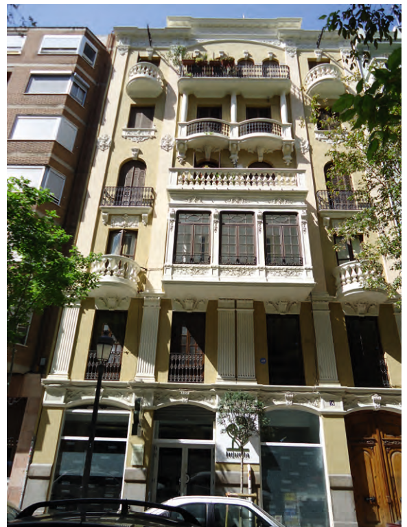
REHABILITACIÓN FACHADA | C/ Conde Altea. Valencia
