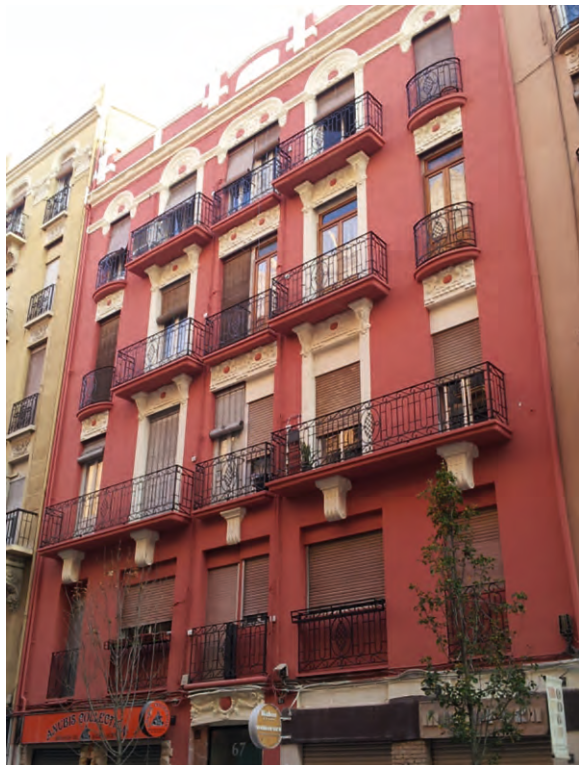
REHABILITACIÓN FACHADA | C/ Cádiz. Valencia
