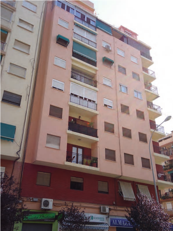
REHABILITACIÓN FACHADA | C/ Centelles. Valencia
