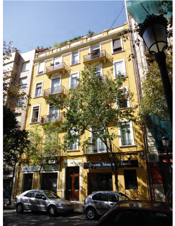
REHABILITACIÓN FACHADA | C/ Almirante Cadarso. Valencia
