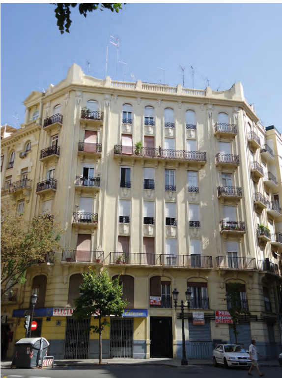
REHABILITACIÓN FACHADA | Ruzafa. Valencia
